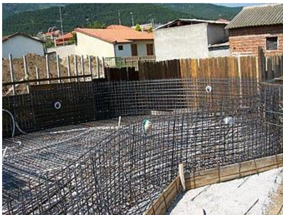
Σιδέρωμα των τοίχων και του πυθμένα κτιστής πισίνας
